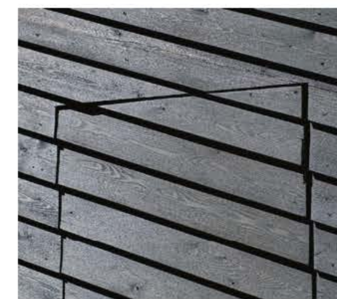
Außentür zum Lagerraum | Exterior door to the storage room
