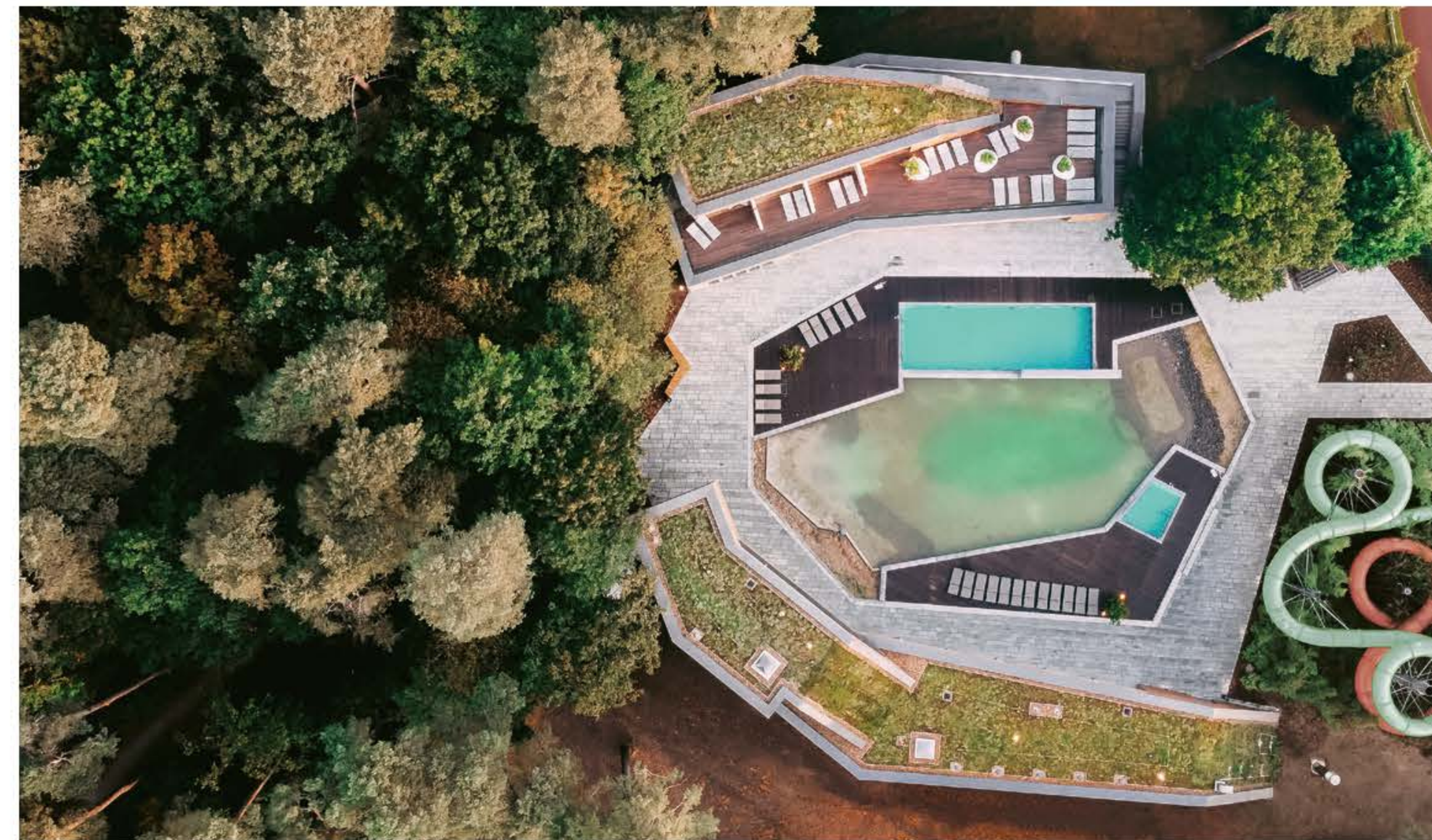
Gesamtanlage aus der Luft | Aerial view of the facility
