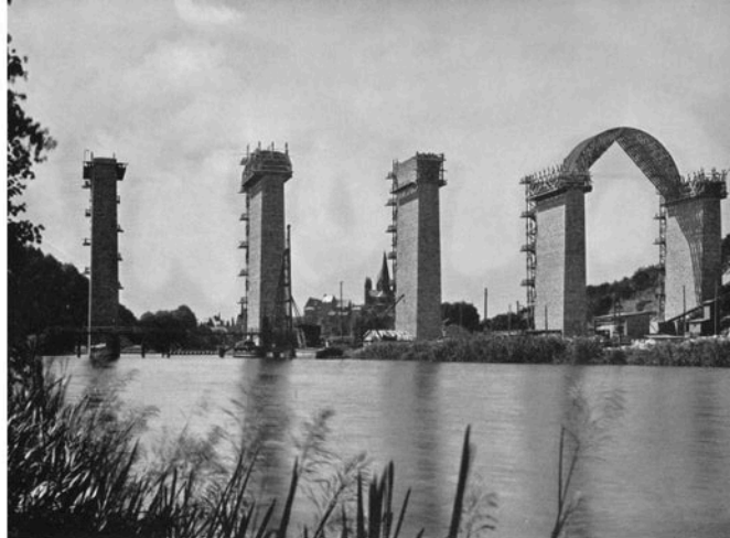
Lahnbrücke bei Limburg Baustelle der Lahnbrücke, entworfen von Paul Bonatz. Blick durch die natursteinverkleideten Pfeiler talab auf Stadt und Dom. Aufnahme Else Hege, 1937.
