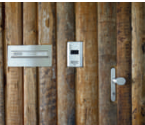
Wenig bearbeitete Produkte, wie hier Holzschwartenbretter an einer Eingangsfassade, sind oft günstig zu beziehen (Architekt Florian Stocker).
