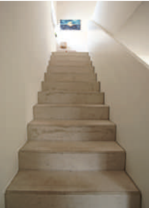
Bauteile wie Treppen aus Beton lassen sich entweder als Fertigteile oder ohne edles Finish deutlich günstiger herstellen (K2 Architekten).
