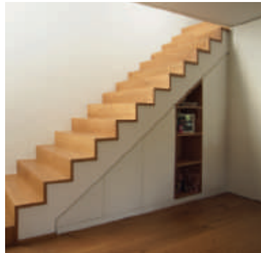
Der Raum unter Treppen lässt sich besonders gut als Stauraum nutzen. So kann an anderer Stelle Fläche eingespart werden (K2 Architekten).
