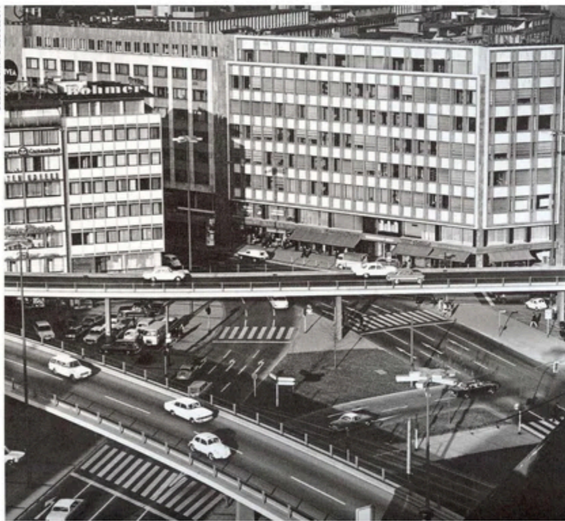
Der Tausendfüßler mit Blick auf die Schadowstraße.
