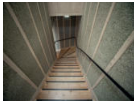
Akustikwände aus Sonnenblumenfasern. Acoustic walls made of sunflower fibres.
