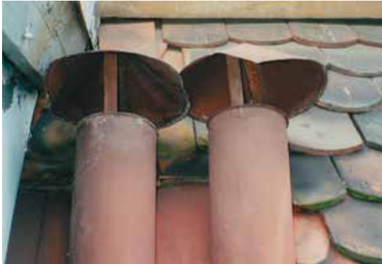
Ein Blick durch das Fernglas auf alte Entlüftungsrohre
